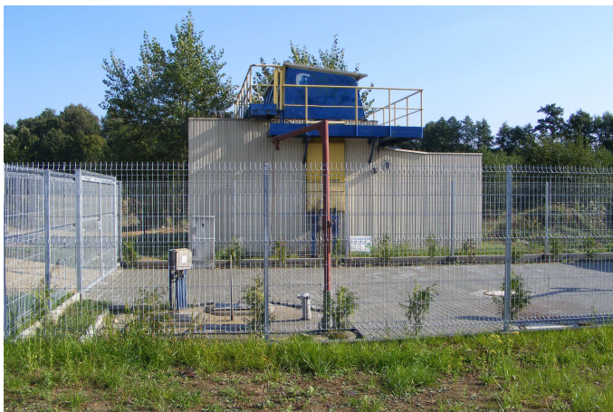
Zdj. nr 6 – oczyszczalnia ścieków
