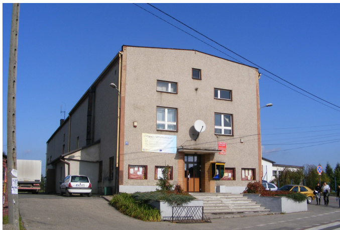
Zdj. nr 11 – Budynek Ośrodka Kultury w Gołkowicach
